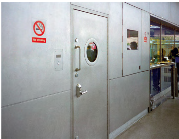
Il laminato inox con finitura pallinata dimostra buona resistenza meccanica in un'area esposta della stazione ferroviaria di Southwark (GB).
