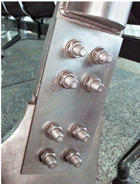
Edelstahl-Teile erfordern Edelstahl-Befestigungsmittel.
