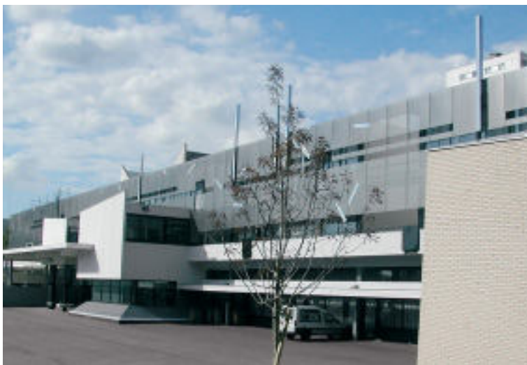
Schulhaus Jean Moulin in Montreuil, F Bauherr: Sodedat/Conseil Général 93, Bobigny, F Architekten: Lipa & Serge Goldstein, Paris, F Foto: Euroslot, Scorbé Clairvaux, F
