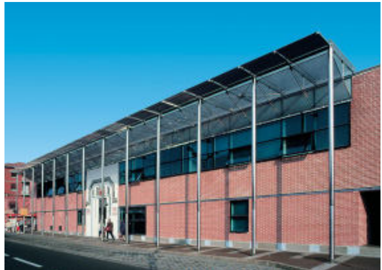
Stadtverwaltung und Polizeistation Toulouse Bauherr: Stadtverwaltung Toulouse, F Architekt: SCP Galavielle, Toulouse, F
