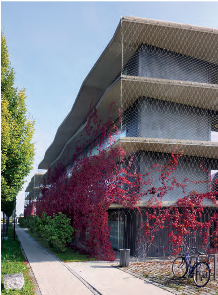
Das Seilnetz und mit ihm die Bepflanzung folgt dem Verlauf der auskragenden Deckenplatten.
