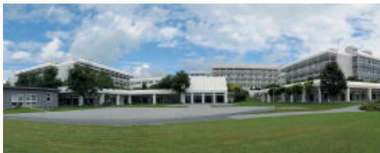
Bauherr: Berufsgenossenschaftlicher Verein für Heilbehandlung Murnau e.V., München, Deutschland Architekten: Köhler & Brinkmann, München, Deutschland Planung und Bauleitung Sanitärtechnik: IBG – Ingenieurbüro Gangl, München, Deutschland Fotos: Medien- und Konferenztechnik BGU-Murnau, Deutschland (oben) Geberit Mapress GmbH, Langenfeld/Marc Frankenhauser, Düsseldorf, Deutschland (unten)
