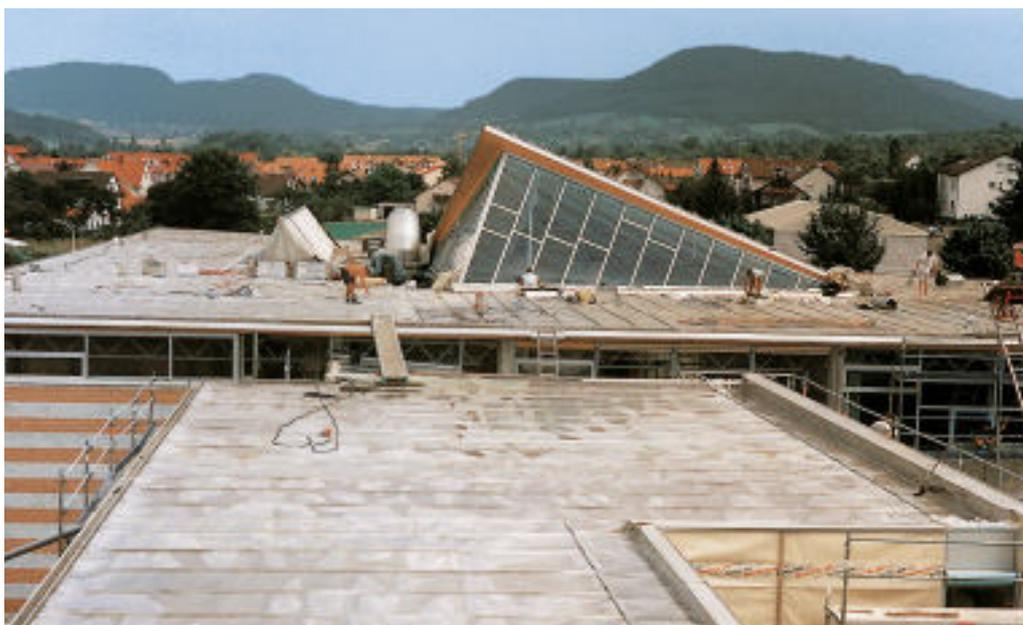
*La toiture en inox soudé avant d'être plantée (ci-contre) et après (page suivante)*
