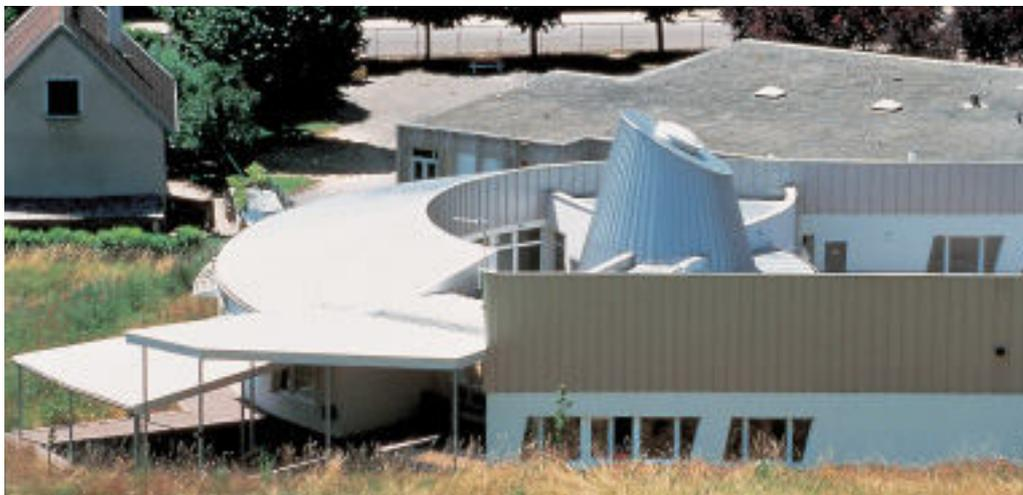
*Les toitures et les garde-corps en partie haute de la façade ont été revêtus d'un même matériau : un inox gris mat.*
