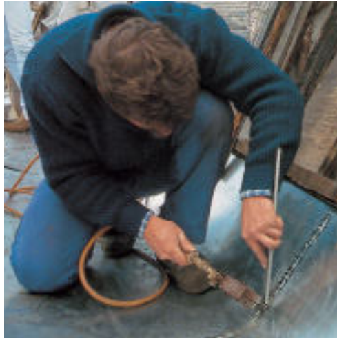
Foto: Brandt Edelstahldach GmbH, Köln
