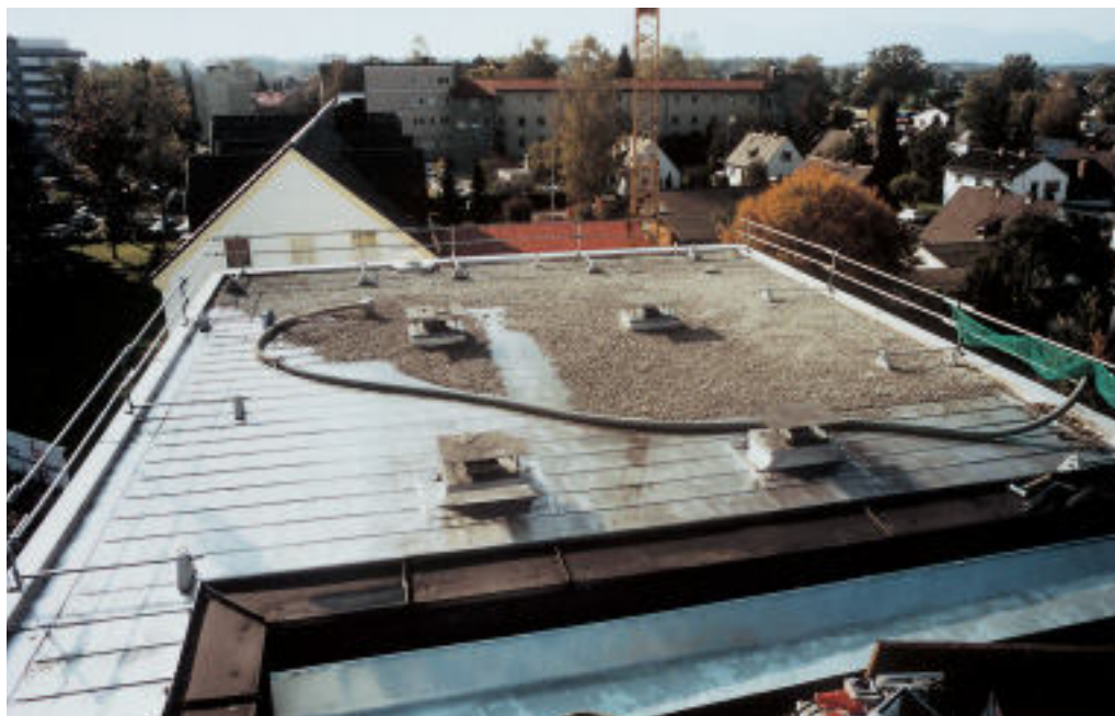
Aufbringung von Kies auf das Dach.
