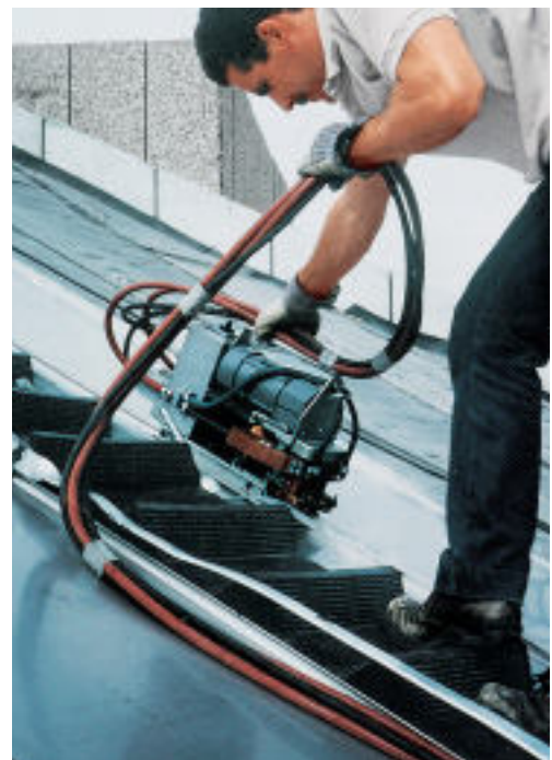
Rollnahtschweißmaschine mit wassergekühlten Elektroden.
