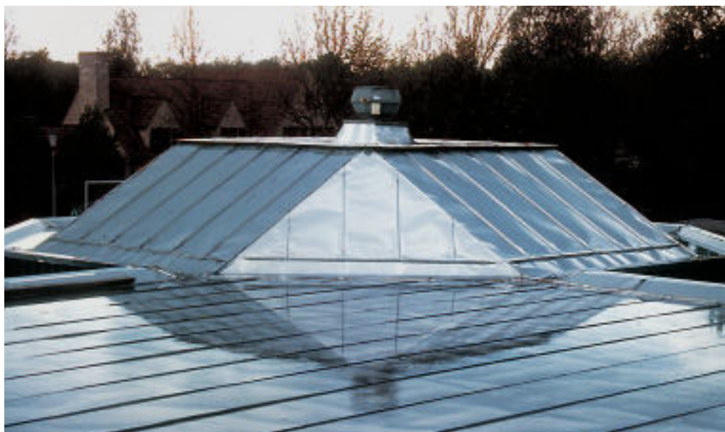
Die Rollnahttechnik ähnelt dem Verfahren, das für die Auskleidung von Trinkwasserbehältern mit Edelstahl Rostfrei eingesetzt wird.
