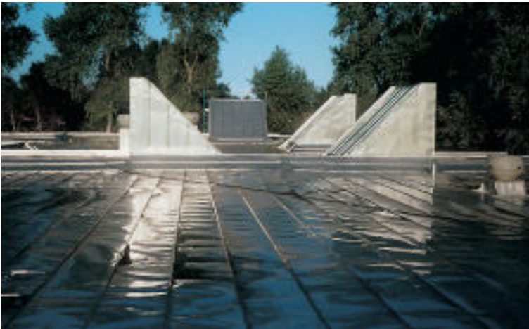
Die werksseitige Standard-Oberflächenausführung 2B ist für viele Dächer die kostengünstigste Lösung.
