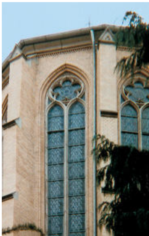
Utilisation d'un acier ferritique étamé, nuance 1.4510, sur les tuyaux de descente d'une église classée
