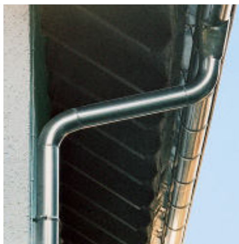
Gouttière et tuyau de descente avec finitions d'usine standard : brillante 2B (à droite) et mate 2D (à gauche)
