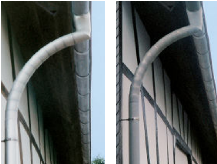
Développement d'une patine sur un acier inoxydable étamé de nuance 1.4404. A gauche : neuf ; à droite : après environ deux ans d'exposition aux intempéries
