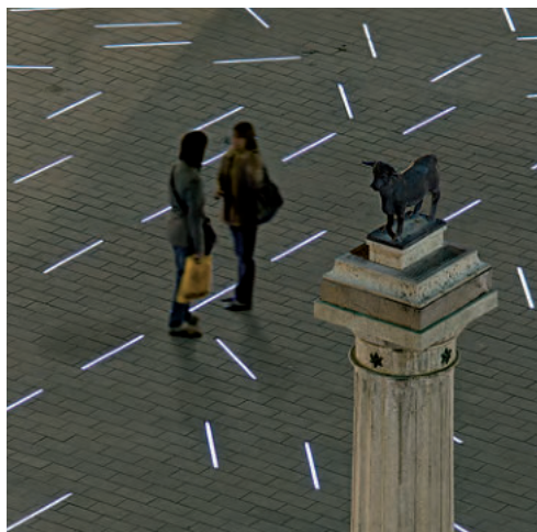
Un guscio di lamiera in acciaio inox EN 1.4304 da 2 mm ed una lastra di vetro laminato proteggono le barre luminose inserite a nastro nella pavimentazione di basalto della piazza.
