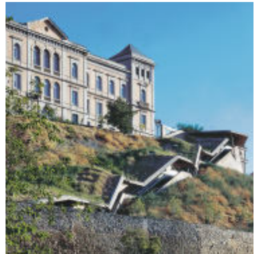
Um den Höhenunterschied von 36 Metern zu überwinden wurde die Rolltreppe, der Topographie angepasst, in sechs Abschnitte unterteilt.
