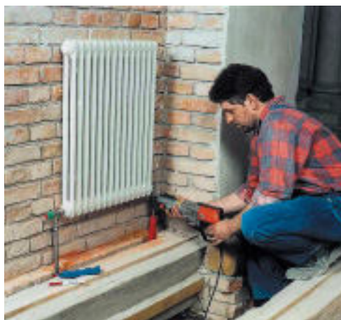
Die Verbindung der Rohre erfolgt mit Presswerkzeugen, die über ein optisches Signal mögliche Fehler schon während des Verpressens anzeigen und somit die Dichtigkeit des Systems garantieren.
