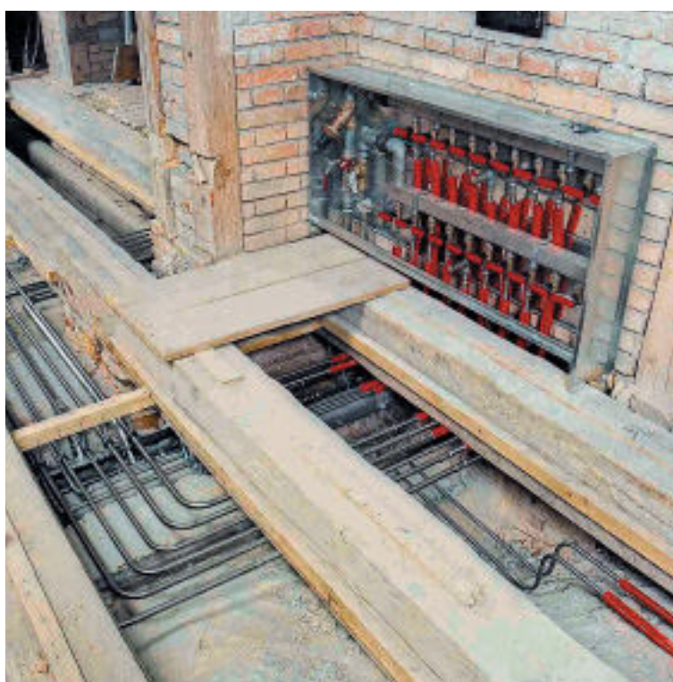
Die Verbindung der Rohre erfolgt mit Presswerkzeugen, die über ein optisches Signal mögliche Fehler schon während des Verpressens anzeigen und somit die Dichtigkeit des Systems garantieren.
