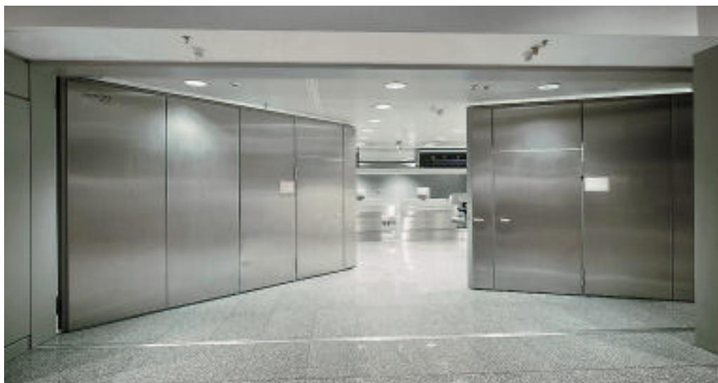
*Das zweiflügelige Brandschutztor im Terminal 2 des Frankfurter Flughafens ist komplett aus Edelstahl gefertigt und entspricht der Feuerwiderstandsklasse T90. Eine eingebaute Schlupftüre dient bei geschlossenem Zustand des Tores als Fluchtweg.*
