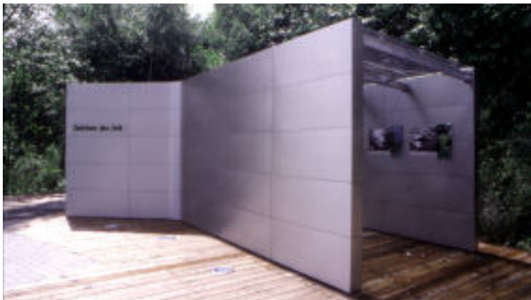
Die Ausstellungspavillons des „Meteorit“-Museums in Essen sind mit zwei-seitig gewalzten Blechen bekleidet.
