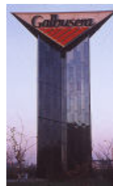
Das Firmensignet eines Süßwarenherstellers ist auf einem 22 m hohen Turm montiert, der mit elektrolytisch gefärbtem Edelstahl Rostfrei bekleidet wurde.
