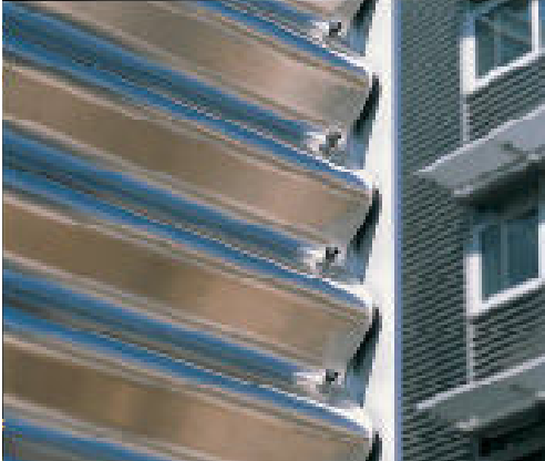
Tôles ondulées en acier inoxydable, fixées à intervalles réguliers par des goujons apparents également en acier inoxydable.
