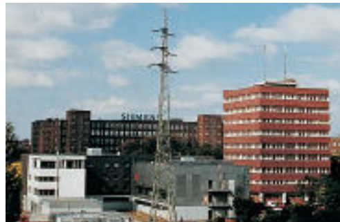
L'apparence extérieure des divers bâtiments diffère, reflétant leurs fonctions internes.
