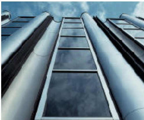
Les gaines techniques sont logées dans les éléments verticaux semi-circulaires de la façade.
