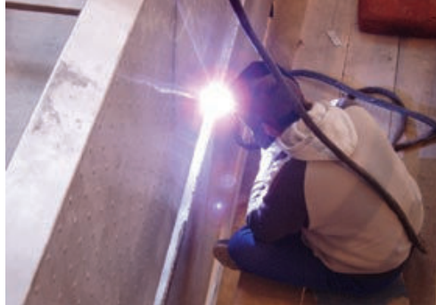
Soudage sur chantier d'une structure de piscine en acier inoxydable.
