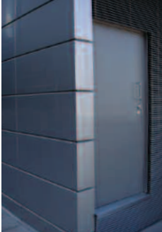
Die aussteifende Wirkung von Ecken kann zur optischen Planität beitragen.
