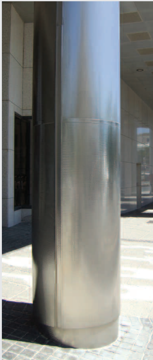
Mustergewalzte Oberflächen vermindern das Risiko sichtbarer Unregelmäßigkeiten und lassen auch leichte Beschädigungen weniger hervortreten.
