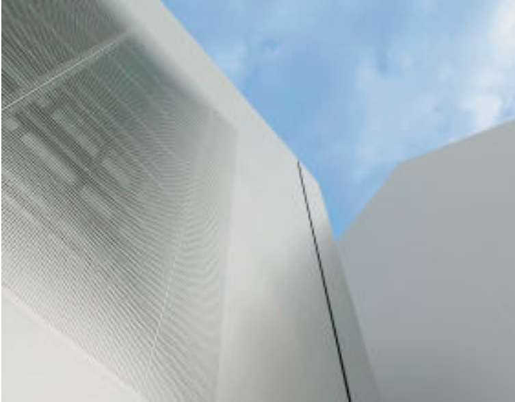
Fassadenbündige Elemente mit laserge- schnittener Lochung verschatten die Fenster.
