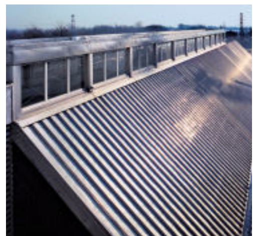
Durch das mit Edelstahl verblechte Oberlicht fällt Tageslicht in die weitgehend geschlossene Ausstellungshalle.
