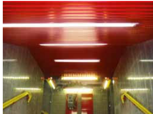
Una bella finitura rossa su acciaio inossidabile alla stazione della Metropolitana in Piazza Carlo, Maiachini a Milano. Foto: Centro Inox, Milano (I)
