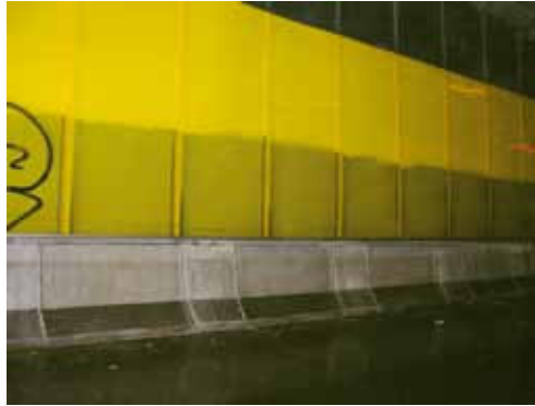
La pulitura mostra l'assenza di corrosione, malgrado le condizioni particolarmente sfavorevoli presenti all'interno di questa galleria. Foto: Centro Inox, Milano (1)
