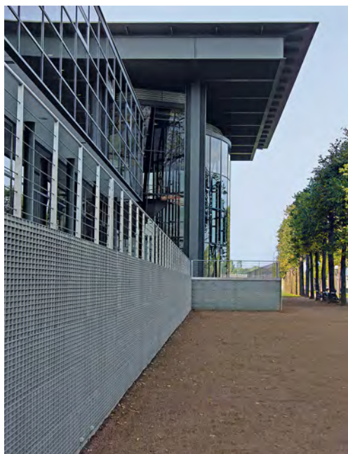
Côté Elbe, le socle en béton du Landtag de Saxe, à Dresde, disparaît sous des grilles en inox.
