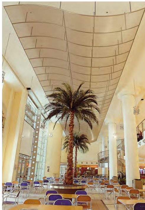
Une vague transparente en métal déployé (EN 1.4301) sert à atténuer les bruits dans l'espace café-restaurant d'un centre commercial de Gênes.
