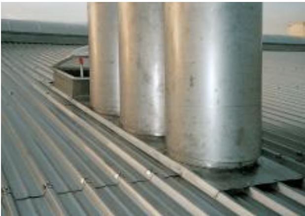
Schornsteine, Rinnen, Fallrohre und Befestigungen sind wie die profilierte Dachdeckung in Edelstahl Rostfrei ausgeführt.
