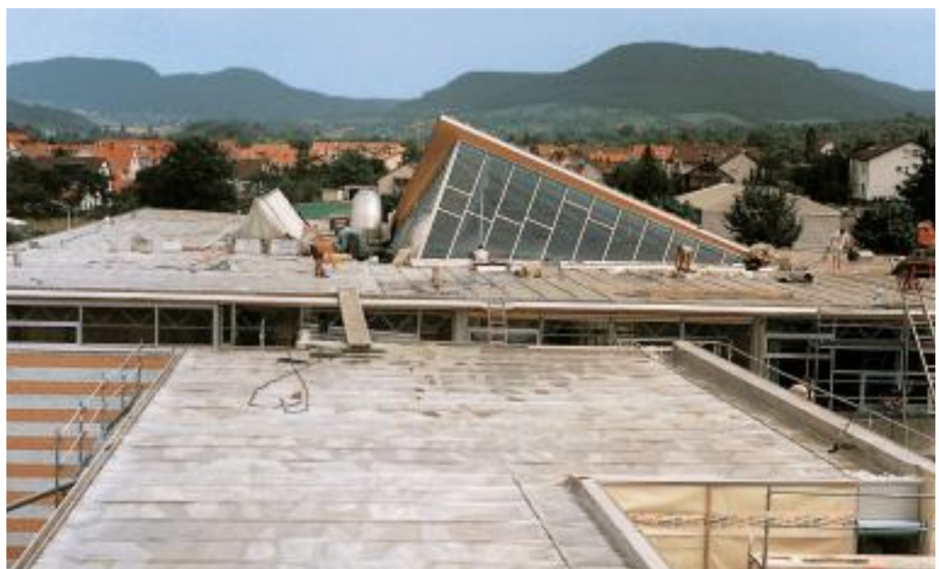
Rollnahtgeschweißte Edelstahl Rostfrei Deckung vor der Dachbegrünung (linke Seite) und danach (rechte Seite).
