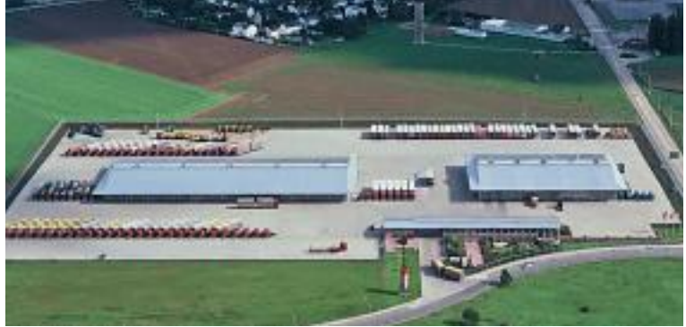
Die Zufahrt zum Gelände erfolgt durch das zweigeteilte Bürogebäude.
