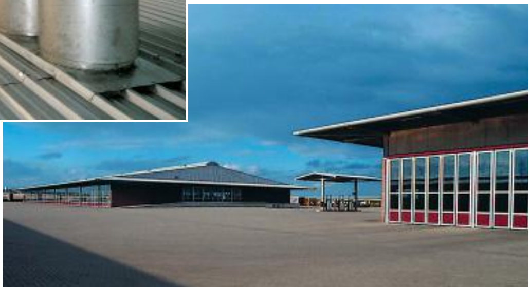
Schornsteine, Rinnen, Fallrohre und Befestigungen sind wie die profilierte Dachdeckung in Edelstahl Rostfrei ausgeführt.
