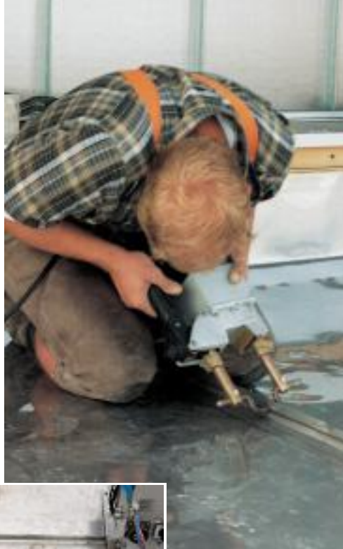
Tragbare Punktschweißzange
