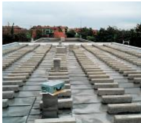
Das Dach kann durch Hafte oder Auflasten gesichert werden.
