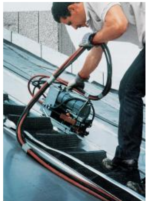
Rollnahtschweißmaschine mit wasser-gekühlten Elektroden.
