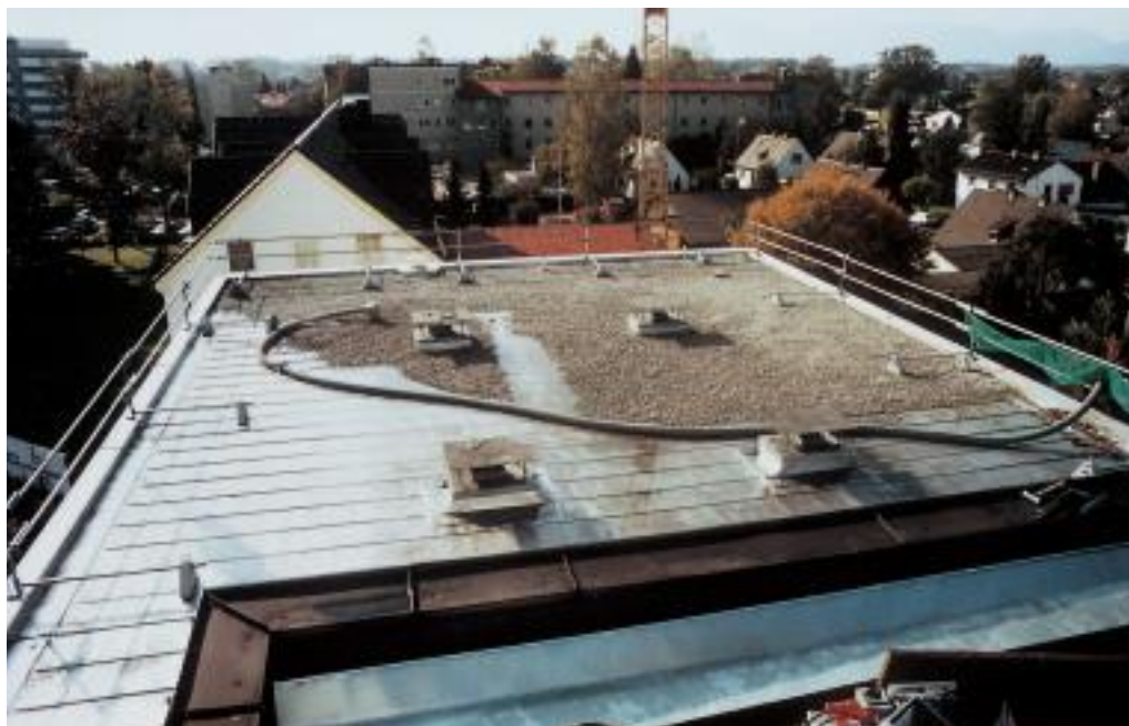
Aufbringung von Kies auf das Dach.
