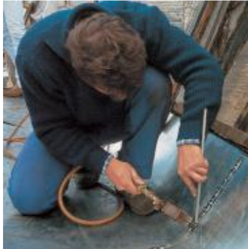
Foto: Brandt Edelstahldach GmbH, Köln
