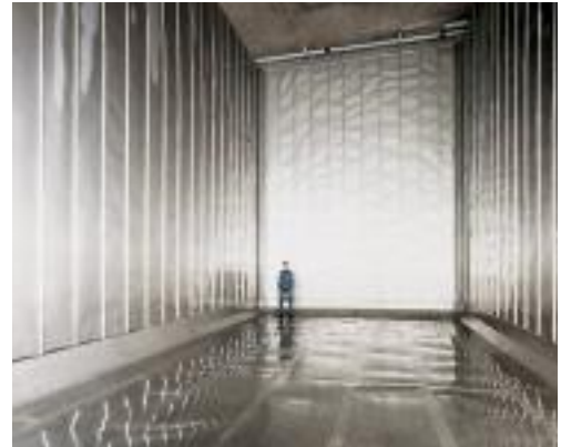
Die Rollnahttechnik ähnelt dem Verfahren, das für die Auskleidung von Trinkwasserbehältern mit Edelstahl Rostfrei eingesetzt wird.
